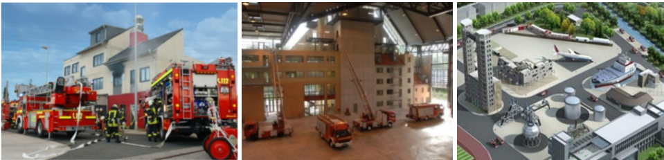
Abbildung 13-4: Übungseinrichtungen: Brandhaus der Feuerwehr Dortmund, Trainingshalle des Instituts der Feuerwehr NRW, virtuelle Abbildung des Trainingszentrums in Shanghai (Quellen: Feuerwehr Dortmund, Institut der Feuerwehr NRW, haagen.com)
